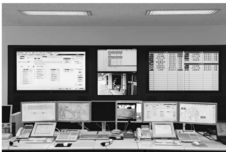
高機能消防通信指令施設
