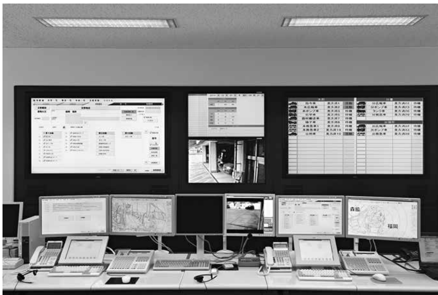
高機能消防通信指令施設
